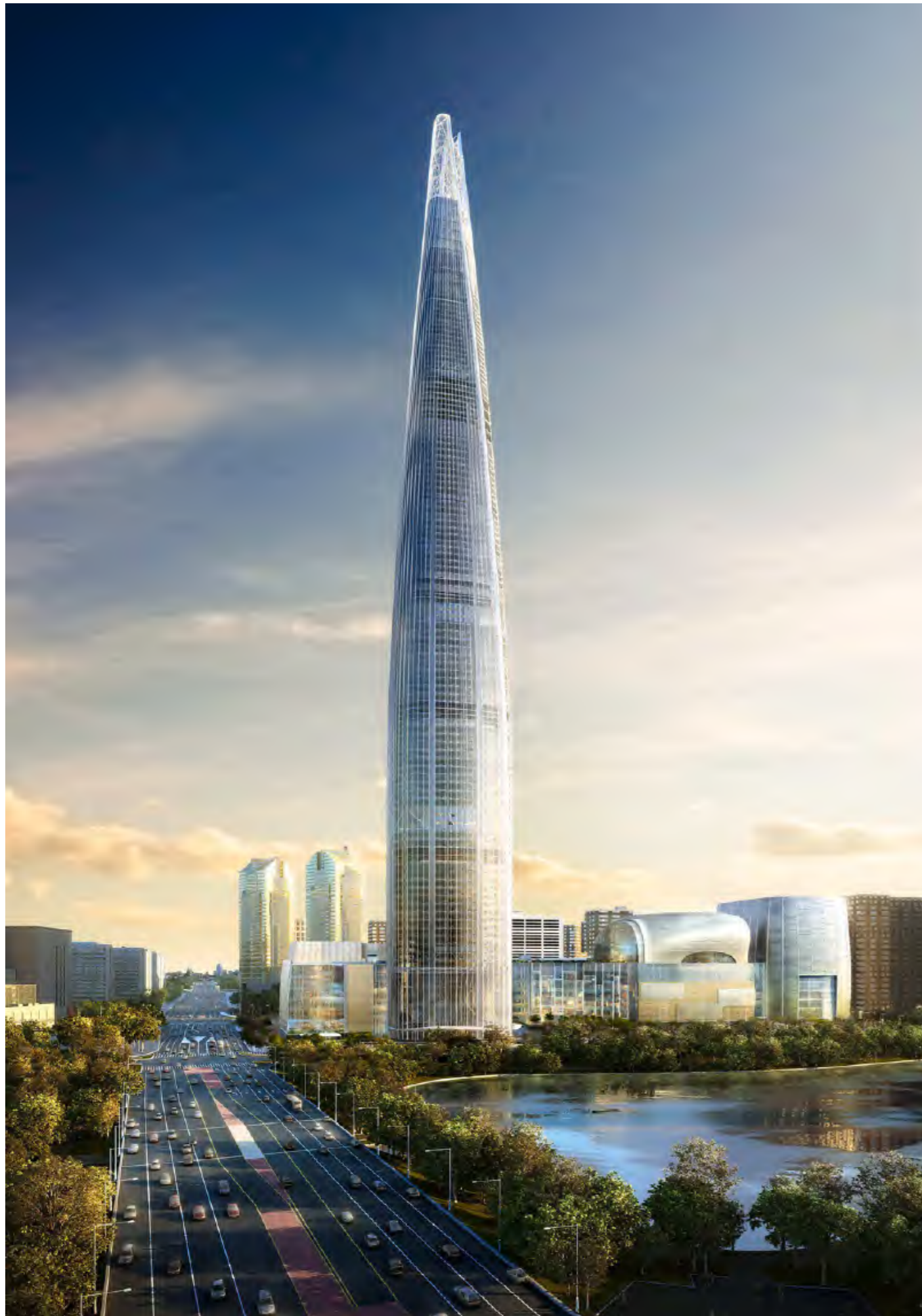
잠실 롯데 월드타워 시그니엘 2016년도 완공. 드레스룸 및 수납가구 223세대
