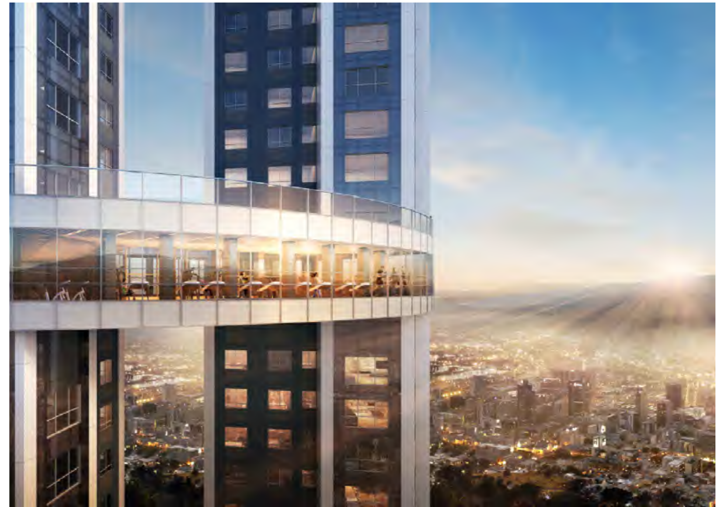
광주광역시 신세계 건설 빌리브 트레비체 2022년 완공, 이탈리아 Guzzini & Fontana 드레스룸 123세대
