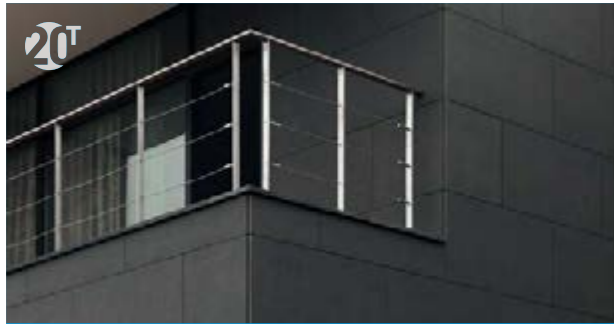
EXTERIOR WALL CLADDING 건물 외벽 마감
